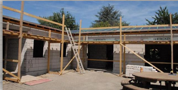
2006: Rohbau des neuen „Skiringssal“ beim Richtfest
